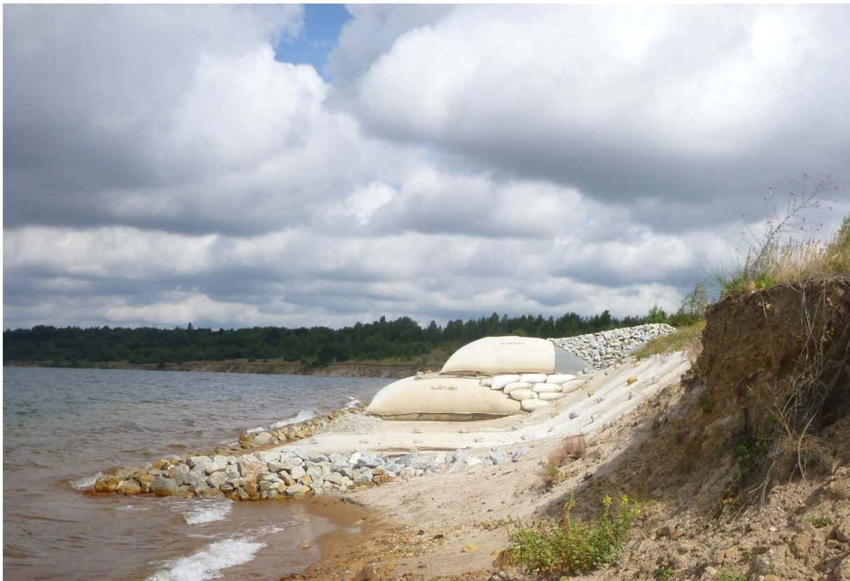
Abbildung 4-2 Ufersicherung mittels GeoTube und Wasserbausteinen am Sedlitzer See (Ortslage Lieske)
