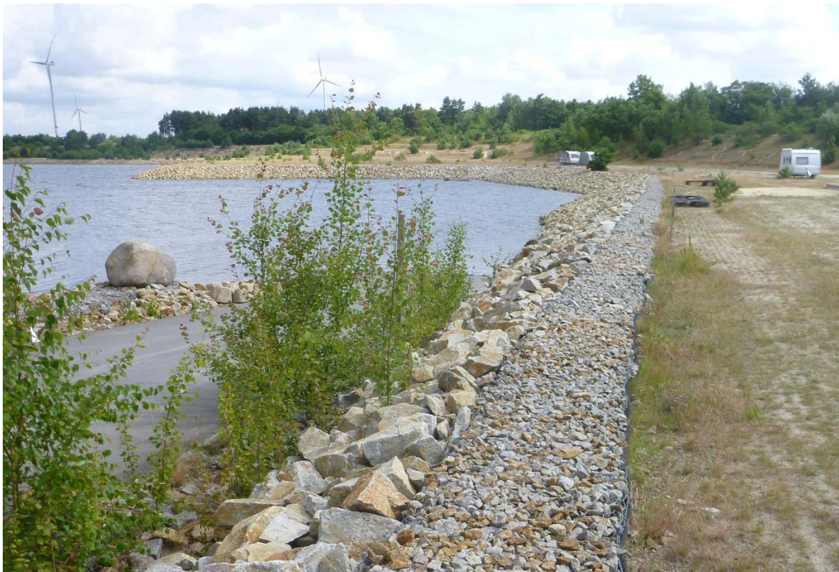
Abbildung 4-3: Ufersicherung mit Gabionen und Steinschüttung am Partwitzer See
