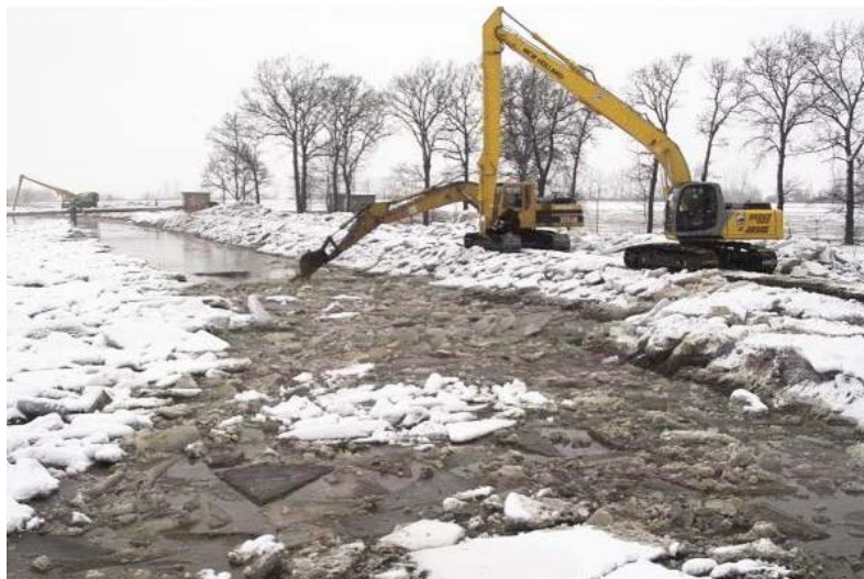
Abbildung 2-5: Einsatz von Langarmbaggern zur Eisentnahme aus der Schwarzen Elster (Quelle: THW Kamenz 2006)
