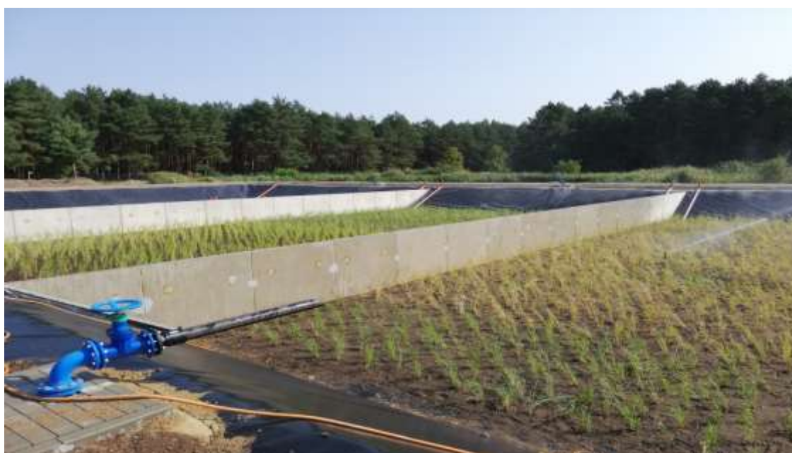
Abb. 16: Klärschlammvererdungsbecken der Kläranlage Friedland (Gubener WAZV)
