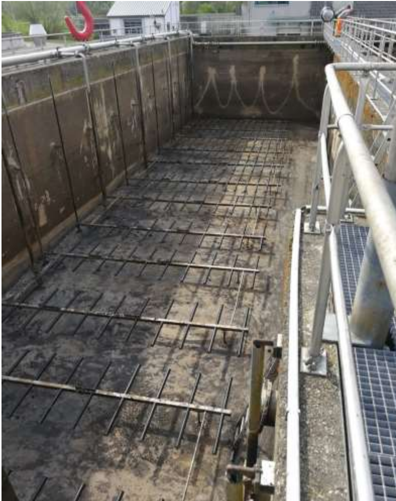
Abb.: 12: Wartungsarbeiten am Belebungsbecken auf dem Klärwerk Kremmen (ZV Kremmen)
