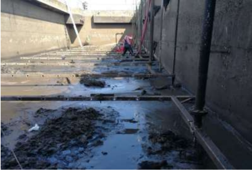
Abb.: 12: Wartungsarbeiten am Belebungsbecken auf dem Klärwerk Kremmen (ZV Kremmen)
