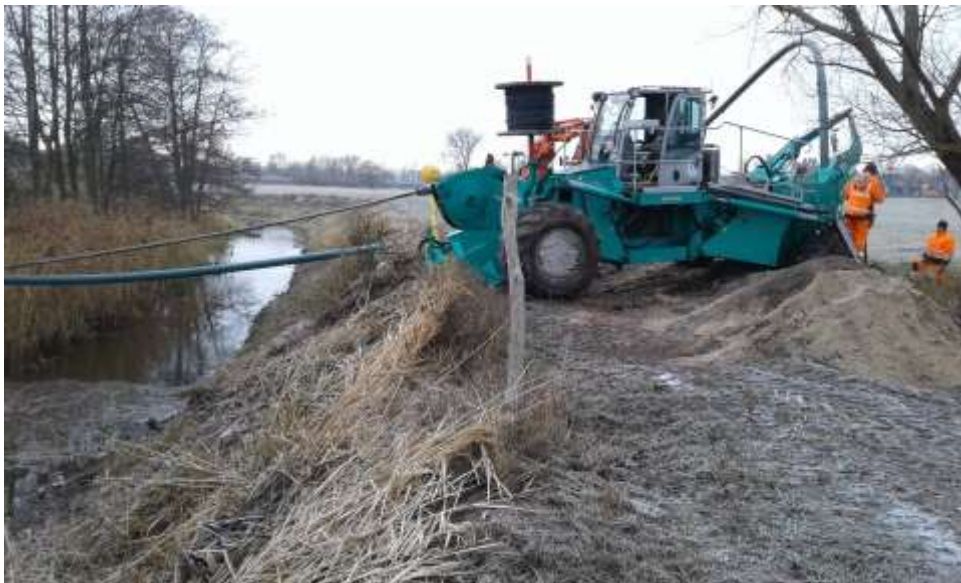
Abb. 7: Einpflügen einer Abwasserdruckleitung durch den Zweckverband Kremmen
