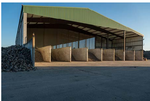
Abb. 3-3: Lagerhalle mit separaten Lagerboxen für unterschiedliche Recycling- und Baustoffmaterialien (Quelle: Matthäi Bauunternehmen GmbH & Co.KG)
