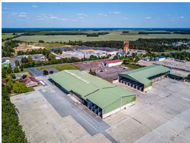
Abb. 3-1: Betriebshof der Firma M-Entsorgung & Umwelttechnik GmbH & Co. KG am Standort Luckau-Altenu aus der Vogelperspektive (Quelle: Matthäi Bauunternehmen GmbH & Co.KG)
