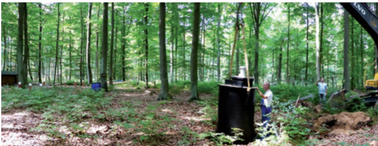
Einbau einer Boden-Sickerwassergewinnungsanlage an der Level II Fläche 1207 (Beerenbusch) Foto: B. HEISTERBERG
