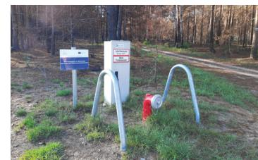
Im Falle eines Brandes muss eine gute Löschwasserversorgung gewährleistet sein. Im Wald werden dazu zahlreiche Löschwasserentnahmestellen gebaut und regelmäßig gewartet.
