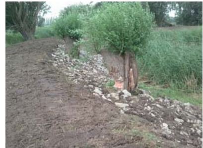
Abb. 48: Steinschüttung als Uferschutz vor wühlenden Tieren
