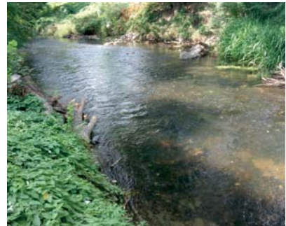
Abb. 30: Eingebauter Stamm zur Ufersicherung in der Dosse bei Hohenofen
