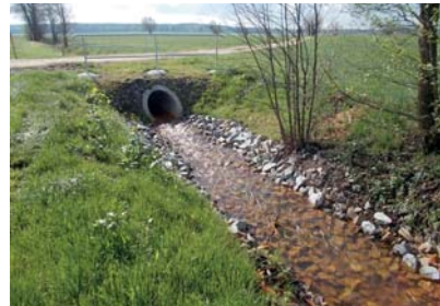
Abb. 24: Steinschüttung zur Sicherung der Gewässersohle
