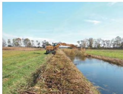
Abb. 12: Maschinelle Krautung mit Mähkorb
