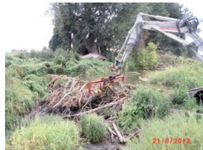
Abb. 41: Entfernen eines Biberdamms
