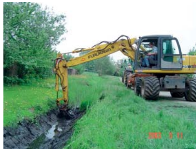
Abb. 16: Maschinelle Grundräumung mit Bagger
