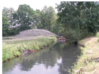
Abb. 17: Schwimmender Saugbagger mit Sprühtechnik
