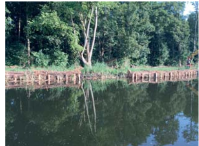
Abb. 35: Ingenieurbioologische Bauweise zur Uferbefestigungen
