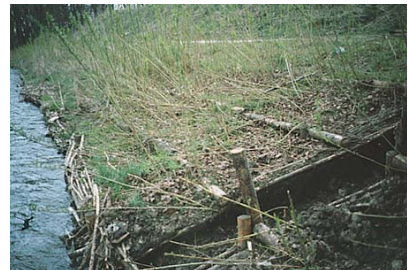
Abb. 31: Weidenspreitlage als Ufersicherung mit Fixierung durch Derbstangen und Rundholzpfähle sowie Fußsicherung durch Faschinen
