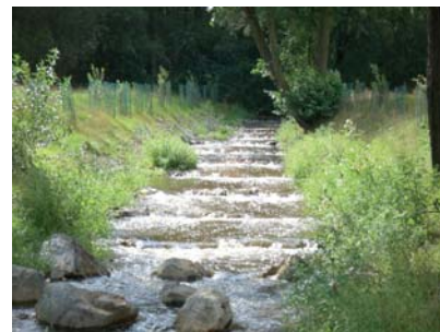
Abb. 25: Schwellen zur Sicherung der Sohle
