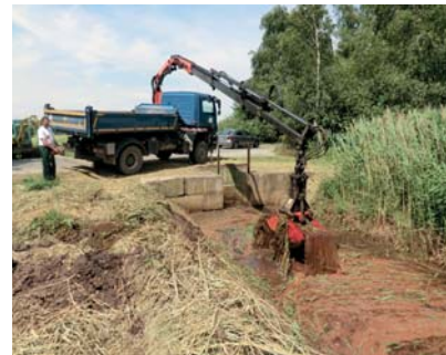
Abb. 21: Beräumung des Abflussprofils von Abflusshindernissen unter Einsatz von Baggertechnik
