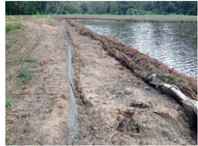
Abb. 47: Edelstahlschutzmatten als Uferschutz an Kanalseitendämmen
