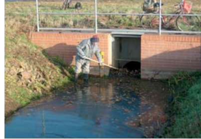
Abb. 20: Beräumung des Abflussprofils von Abflusshindernissen von Hand
