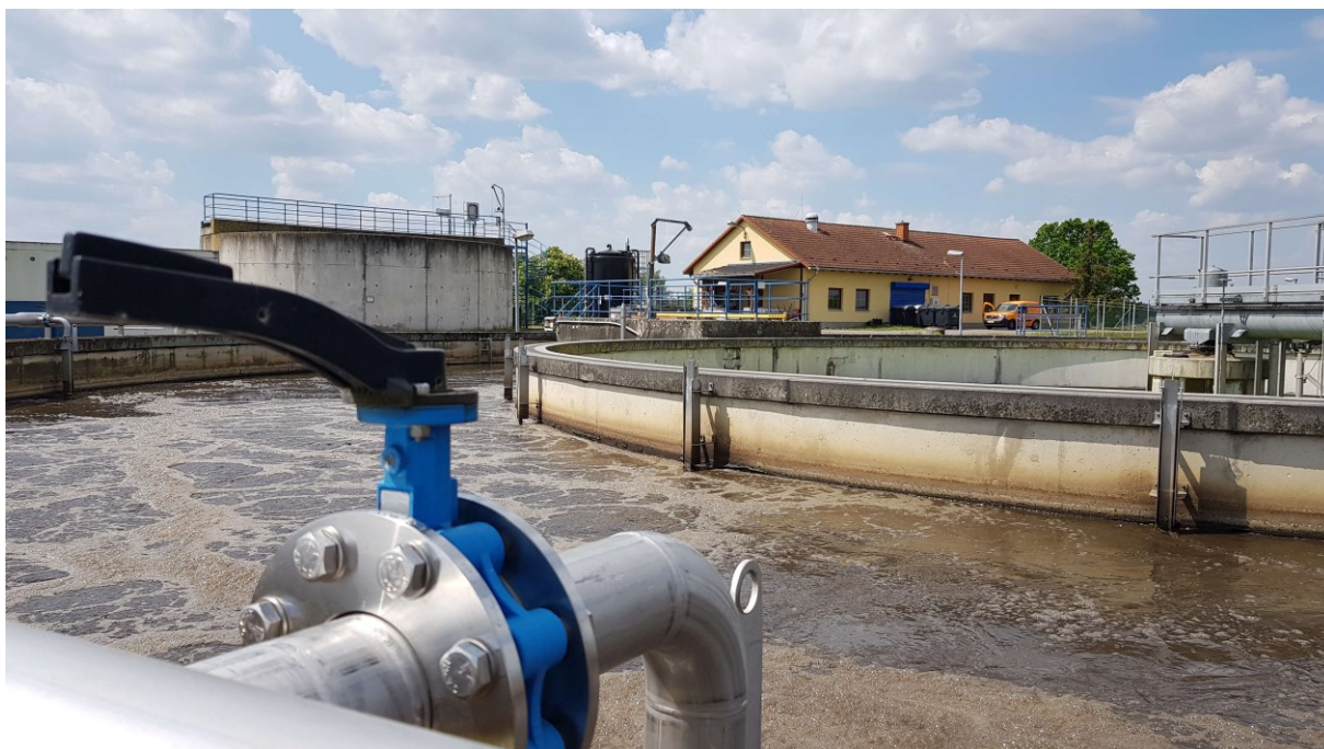
Abbildung 13: Belebungsbecken auf der Kläranlage Schönwalde (Herzberger WAZV)
