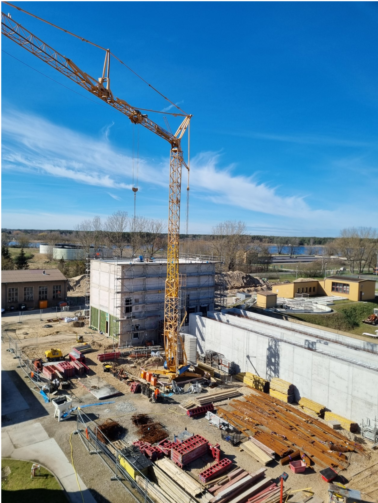
Abbildung 7: Neubau des Zulaufbereichs inklusive Messschacht, Einlaufbauwerk, Rechengebäude und Sandfang auf der Kläranlage Brandenburg Briest (BRAWAG GmbH)
