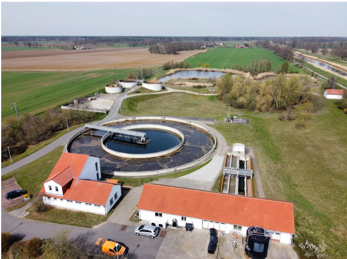
Abbildung 3: Kläranlage Uebigau (Herzberger WAZV)
