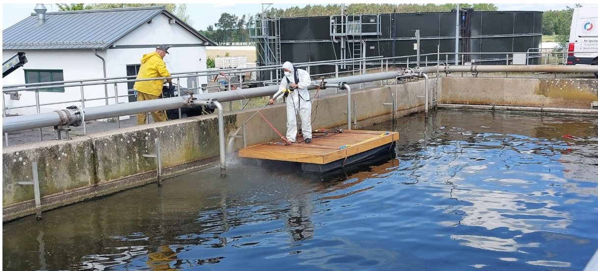
Abbildung 6: Reinigungsarbeiten an der Beckenkronen eines Belebungsbeckens der Kläranlage Kremmen (ZV Kremmen)
