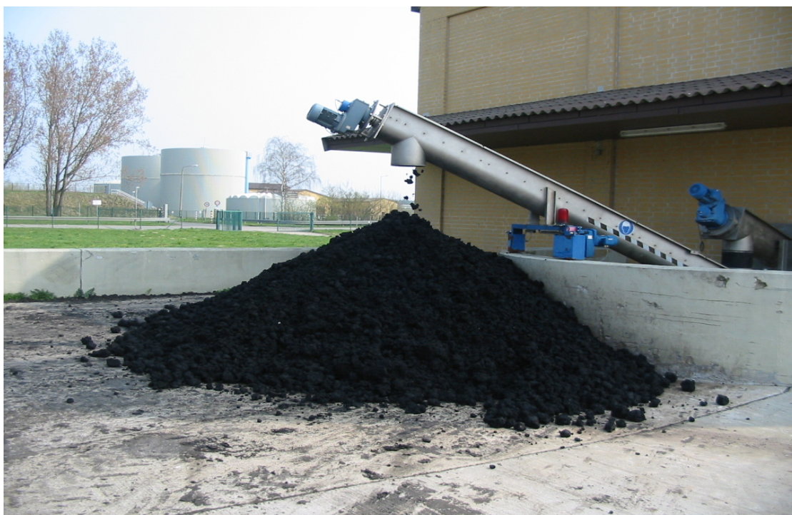
Abb. 12: Lagerung des behandelten Klärschlamms auf der Abwasserbehandlungsanlage Brandenburg-Briest
