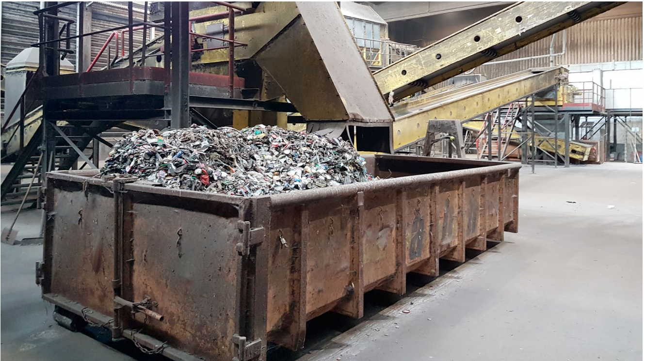
Abbildung 12: Mechanisch-Biologische Abfallbehandlungsanlage (MBA) Schwanebeck: Abwurf der aussortierten Metalle aus dem angelieferten Siedlungsabfall in Transportcontainer © Abfallbehandlungsgesellschaft Havelland mbH
